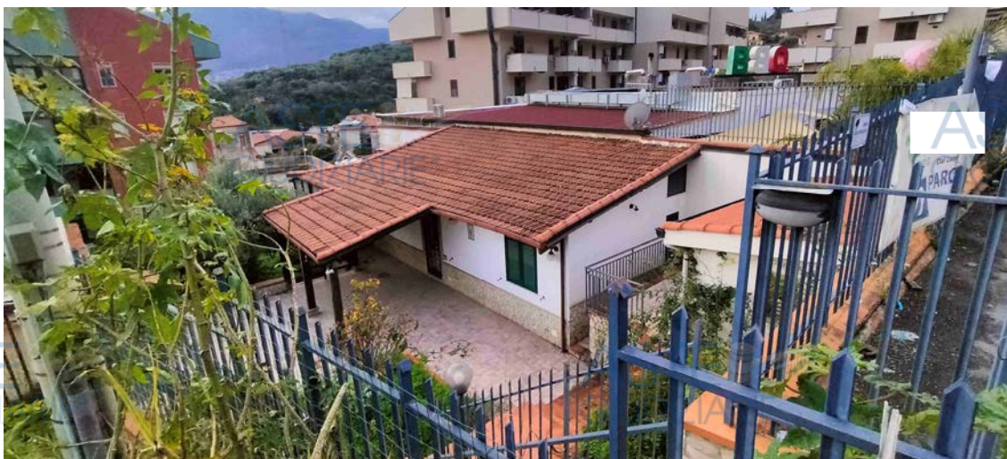
Foto 2 - Vista Immobile con corpo accessorio (locale di sgombero) e corte di pertinenza
