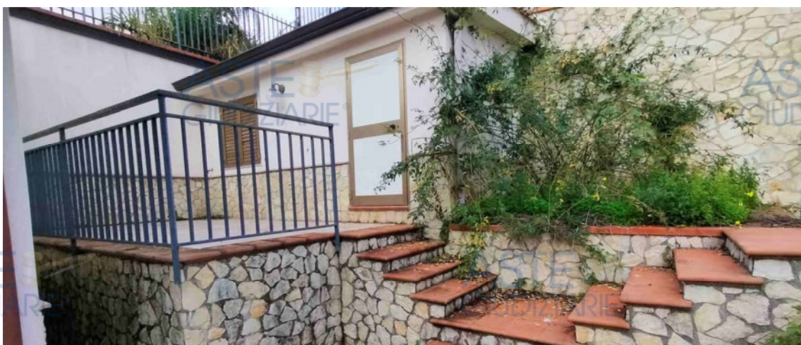
Foto 3 - Vista corpo accessorio (locale di sgombero)
