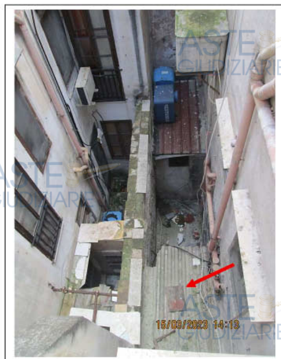
Foto n. 12. Chiostrina interna del fabbricato con il corpo edilizio realizzato ad ampliamento della superficie dell'immobile (indicato con la freccia)
