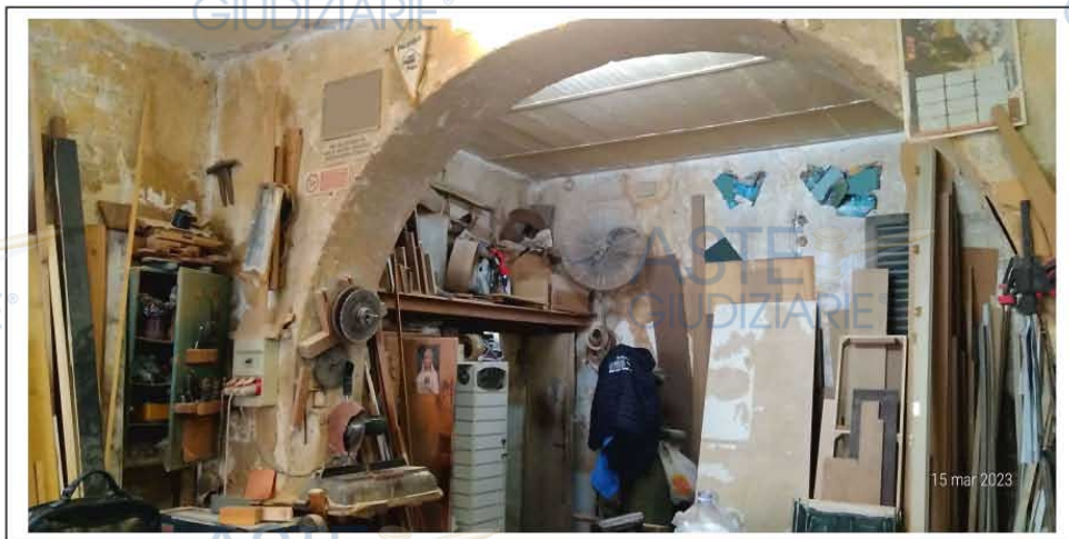
Foto n. 6. Primo ambiente del magazzino collegato al secondo vano tramite un arco in muratura
