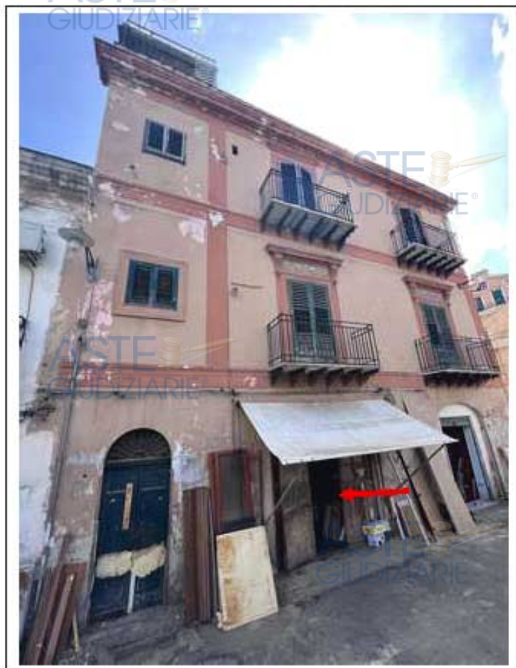
Foto n. 1. Prospetto su Piazza Vincenzo Libanesi. Con la freccia è indicato l'ingresso al magazzino pignocato
