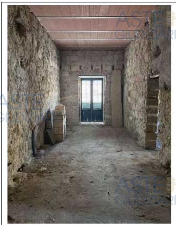
Foto n. 10-11. Immobile identificato al sub. 13. Ambiente di ingresso con affaccio su Vicolo II del Celso
