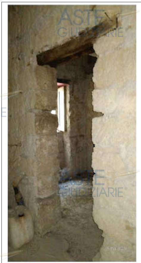
Foto n. 16. Immobile identificato al sub. 13. Apertura di collegamento tra l'ambiente di ingresso e il vano indicato come cucina nella planimetria catastale di impianto
