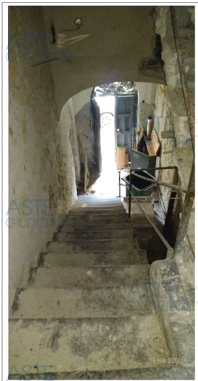
Foto n. 3. Scala con accesso da Piazza Linares n. 6 che conduce ai beni pignorati del primo e secondo piano del fabbricato (sub. 13 e sub. 16)
