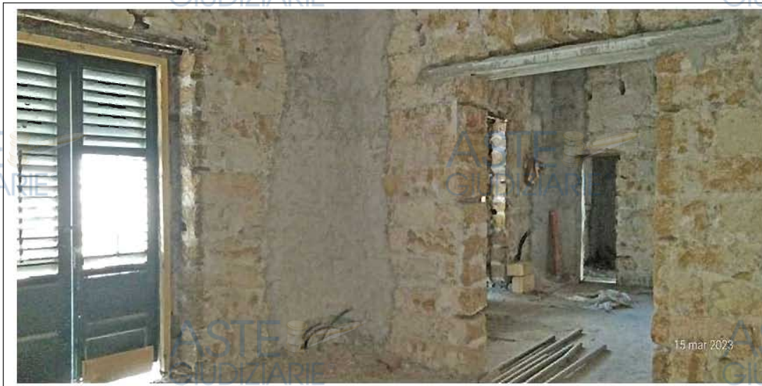
Foto n. 23-24. Immobile identificato al sub. 13. Ambienti prospettanti su Piazza Linares
