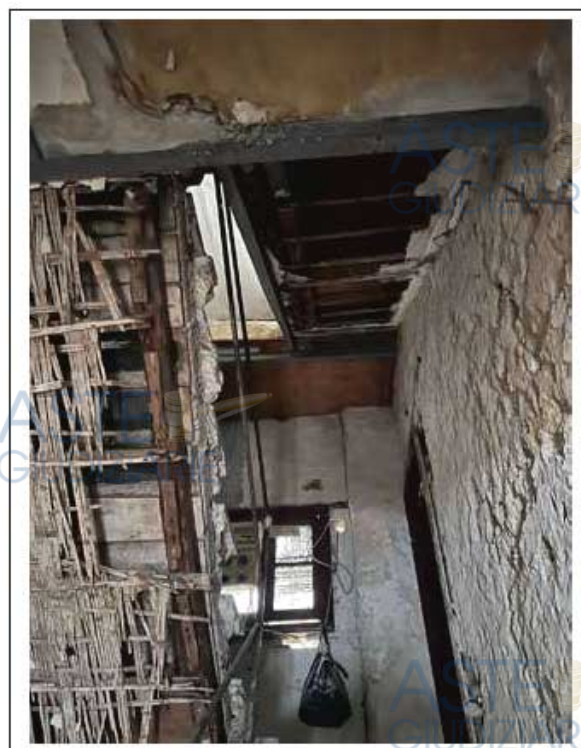
Foto n. 4-5. Scala con accesso da Piazza Linates n. 6 che conduce ai beni pignorati del primo e secondo piano del fabbricato (sub. 13 e sub. 16)
