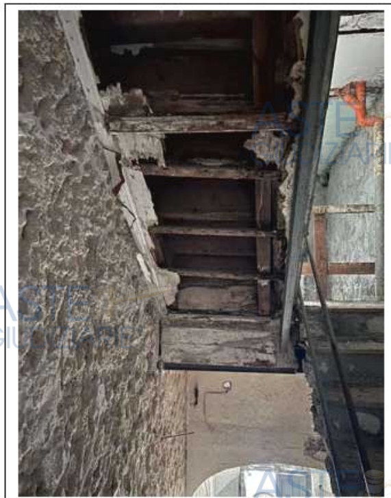
Foto n. 6-7. Scala con accesso da Piazza Linarea n. 6 che conduce ai beni pignorati del primo e secondo piano del fabbricato (sub. 13 e sub. 16)
