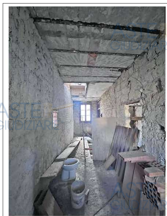
Foto n. 25-26. Scala comune con accesso da Piazza Linares n. 6. Rampa che conduce all'immobile identificato al sub. 16 al secondo piano.
