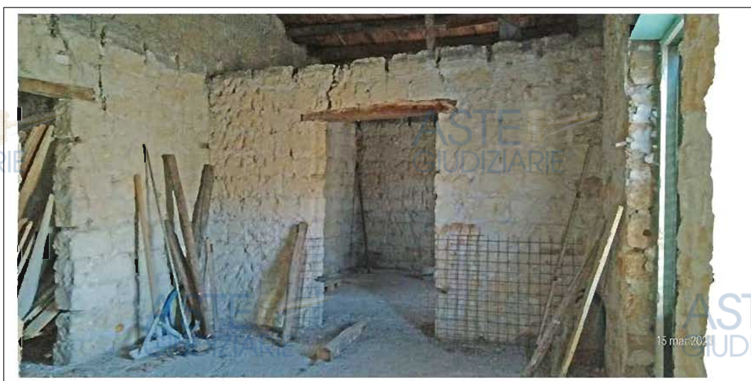
Foto n. 35-36. Immobile identificato al sub. 13. Ambienti prospettanti su Piazza Linares
