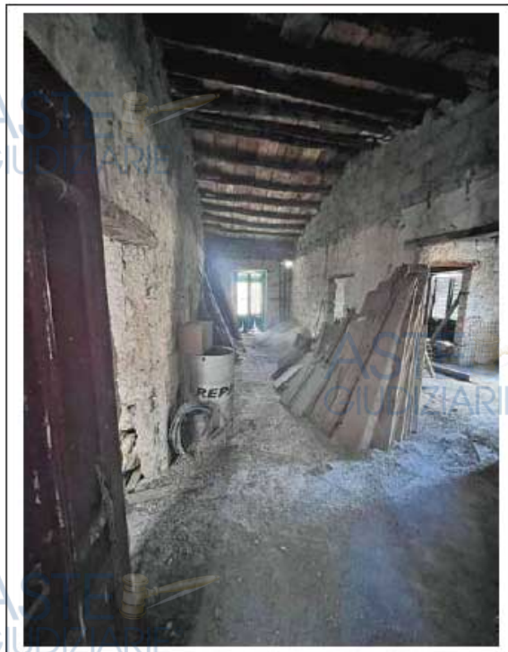
Foto n. 29. Immobile identificato al sub. 16. Ambiente di ingresso con affaccio su Vicolo II del Celso
