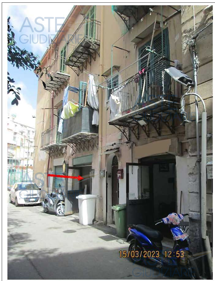
Foto n. 1. Ingresso dell'immobile prospettante su vicolo II del Celso.
