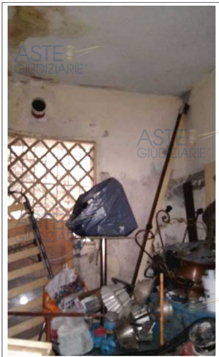
Foto n. 8. Vano prospettante sulla chiostrina interna al fabbricato di cui fa parte il bene pignotato
