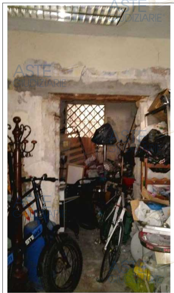
Foto n. 4-5. Vano adiacente al locale di ingresso
