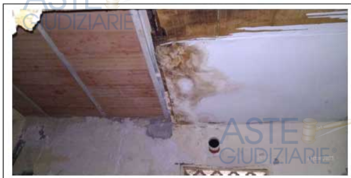
Foto n. 9. Vano prospettante sulla chiostrina interna al fabbricato. Soffitto in cui è stata parzialmente sostituita la vecchia struttura in legno con una in profili di acciaio e laterizi
