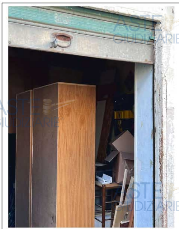
Foto n. 3-4. Ingresso al magazzino identificato al sub. 11 da Piazza Linares n. 8
