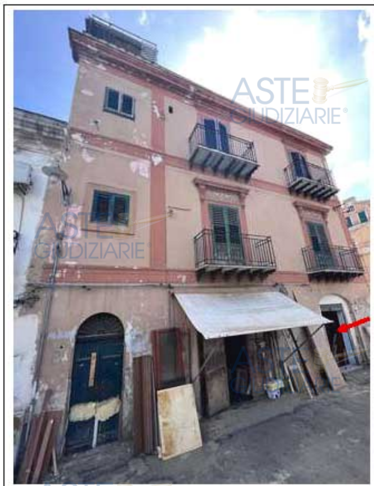
Foto n. 1. Ingresso al magazzino identificato al sub. 11 da Piazza Vincenzo Linares n. 8, indicato con la freccia rossa
