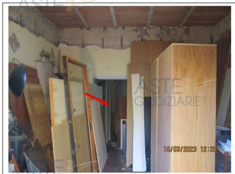
Foto n. 5. Interno del magazzino identificato al sub. 11. Sulla parete di fondo, indicata con la freccia, si trova l'apertura di collegamento con il magazzino individuato al sub. 12.
