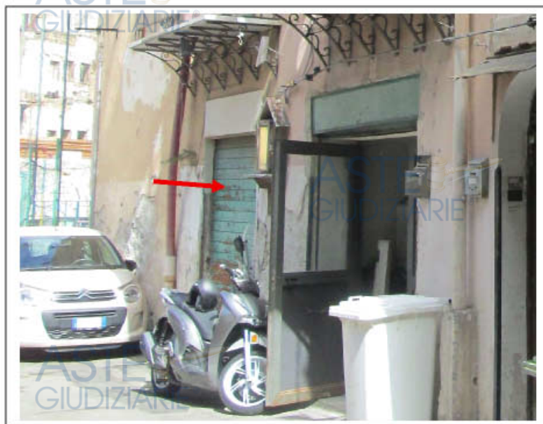
Foto n. 8. Ingresso da via II del Celso del magazzino identificato al sub. 12
