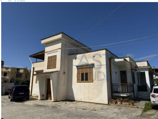
Foto n. 1. Fabbricato in cui ricade l'immobile
