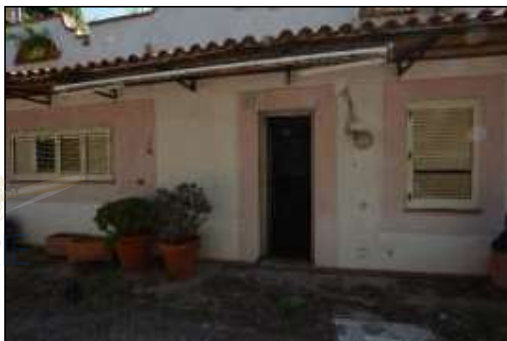
All. 13 – Foto 37 ingresso dal vialetto carrabile
