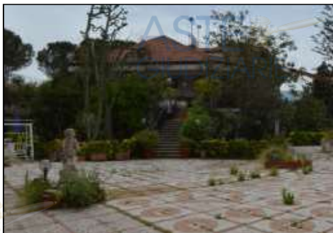
All. 13 – Foto 3 Ingresso secondario al primo piano della villa dalla scalinata
