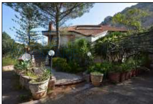
All. 13 – Foto 2 Ingresso principale al primo piano della villa dalla scalinata
