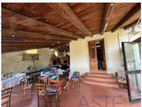
Foto 6 copertura in legno porticato esterno
