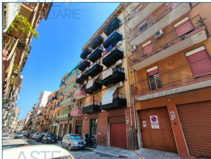
Edificio sito in via Scillato n. 60
