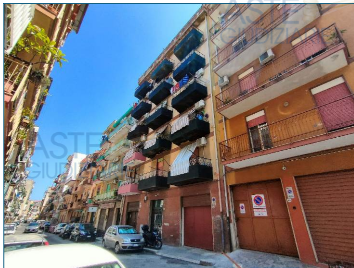
Edificio sito in via Scillato n. 60
