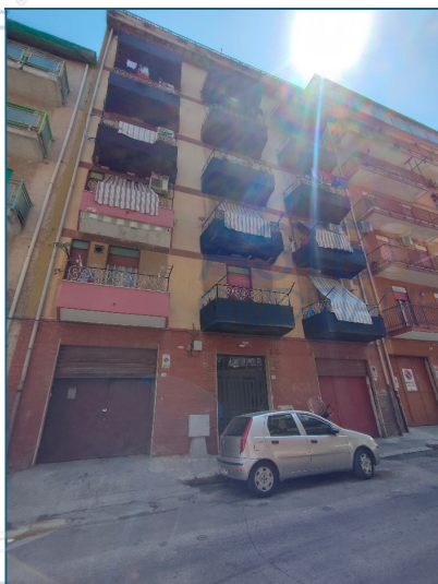
Edificio sito in via Scillato n. 60
