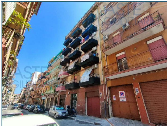
Edificio sito in via Scillato n. 60
