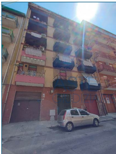
Edificio sito in via Scillato n. 60
