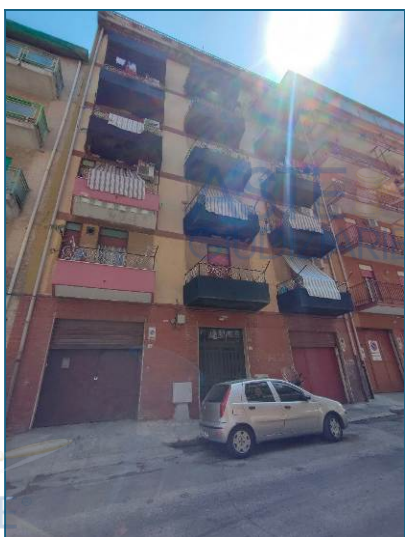
Edificio sito in via Scillato n. 60
