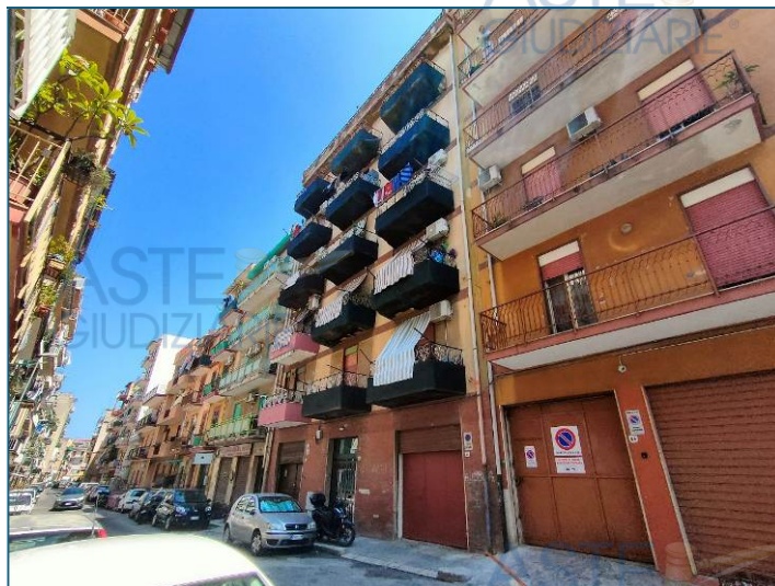
Edificio sito in via Scillato n. 60
