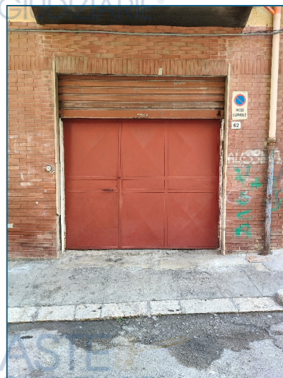
Portone metallico di accesso all'immobile
