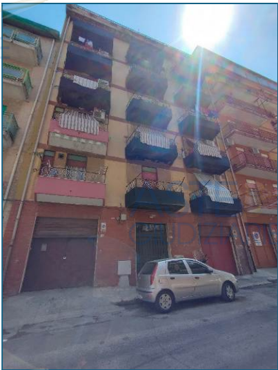
Edificio sito in via Scillato n. 60
