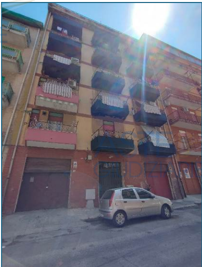
Edificio sito in via Scillato n. 60
