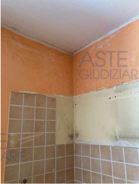
Foto n. 11 tracce infiltrazioni terzo piano
