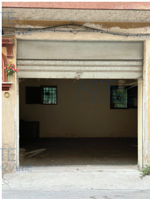
Foto 3 - Ingresso al garage con salacinesca metallica.
