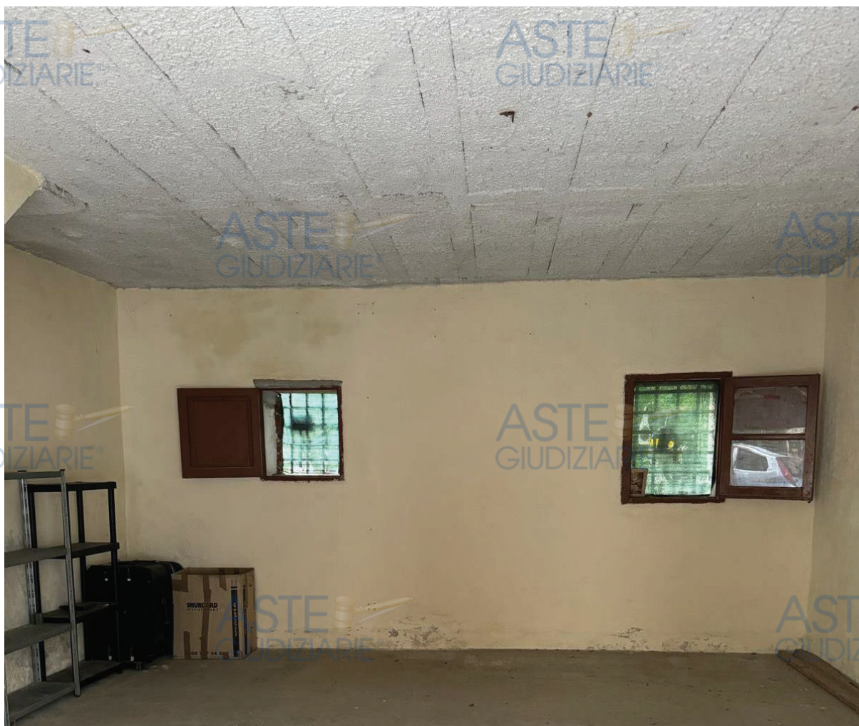
Foto 5 – Interno del garage
