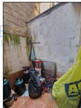
All. 10 – Foto 11 pozzo luce
