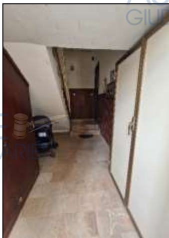
All. 10 – Foto 3 Androne della palazzina di Via Kaggera, 46
