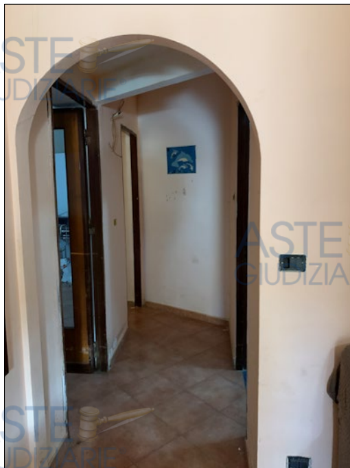
Figura 17: Particolare del corridoio che distribuisce i vari ambienti del lato sud dell'immobile
