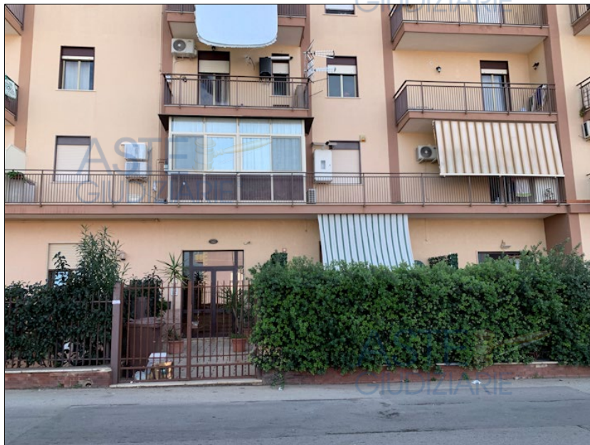
Figura 6: Particolare del prospetto principale in corrispondenza dell'immobile pignorato, al piano terra
