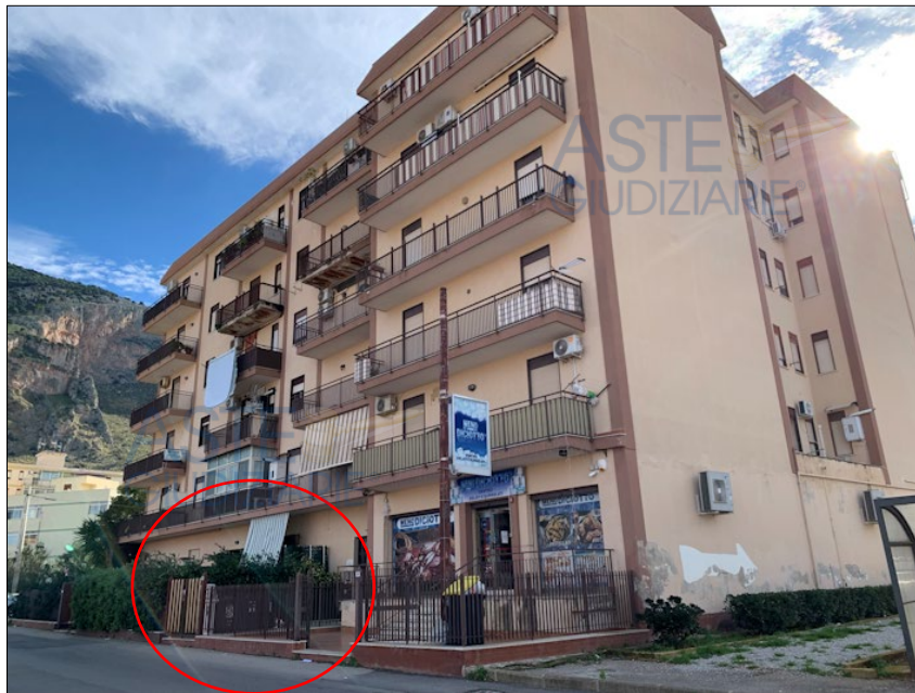
Figura 5: Ripresa del prospetto principale, sulla Via Monsignor Siino, del fabbricato in cui sorge l'immobile pignorato
