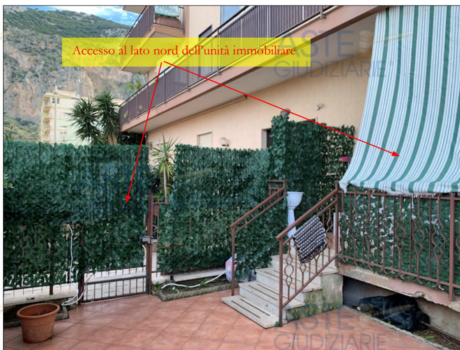
Figura 8: Inquadratura della corte sul lato nord dell'immobile pignorato, prospiciente la Via Monsignor Siino
