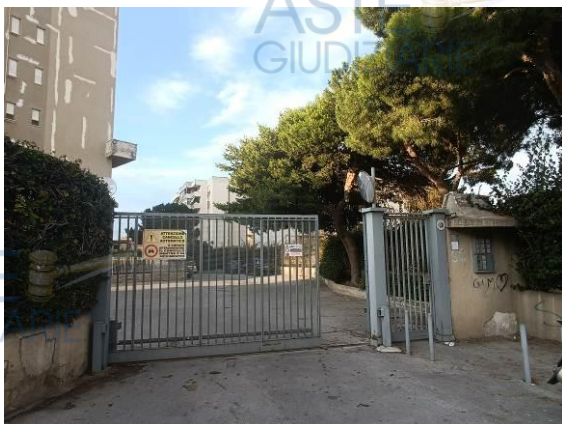
Fig. 7 Ingresso Via G. Cirincione n. 64.
