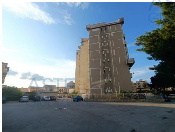
Fig. 8 Prospetto ovest e area condominiale.
