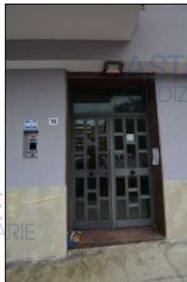
All. 14 – Foto 1 Ingresso edificio di Via F. Speciale n. 79
