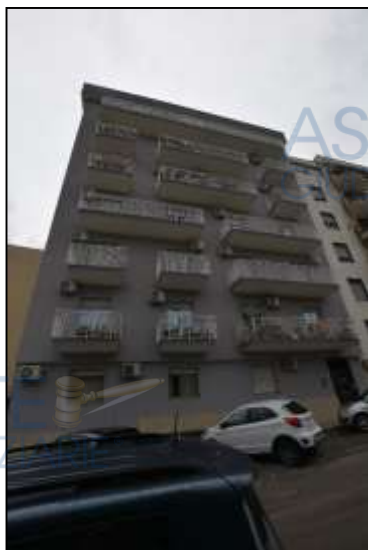
All. 14 – Foto 1 Edificio di Via F. Speciale n. 79
