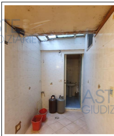
Foto n. 9 accesso al wcb
