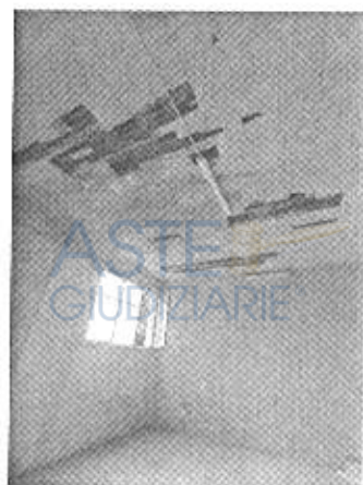
Figg. 24, 25 Degrado intradosso solaio.
