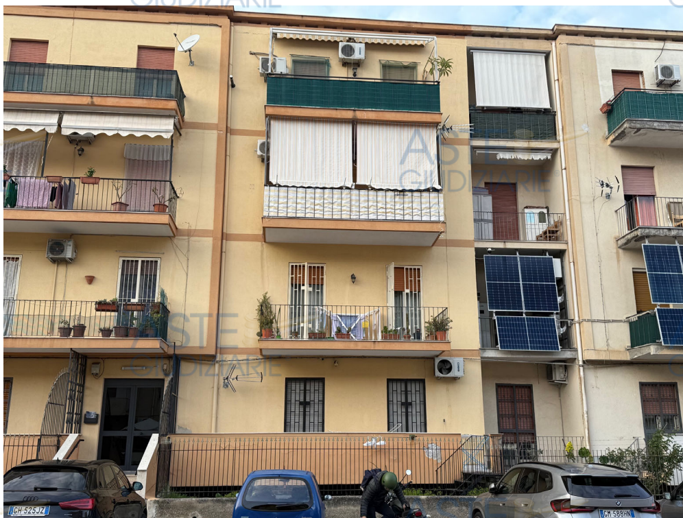
Foto n. 1 – L'edificio visto dalla via Cammarano
