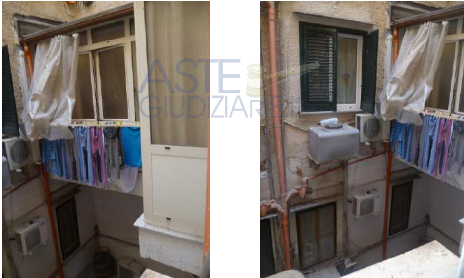
Figg. 17, 18 Particolare della lavanderia vista dall'esterno.
