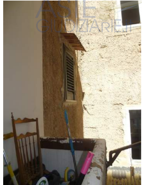
Fig. 29 Finestra bagno vista dall'esterno.
