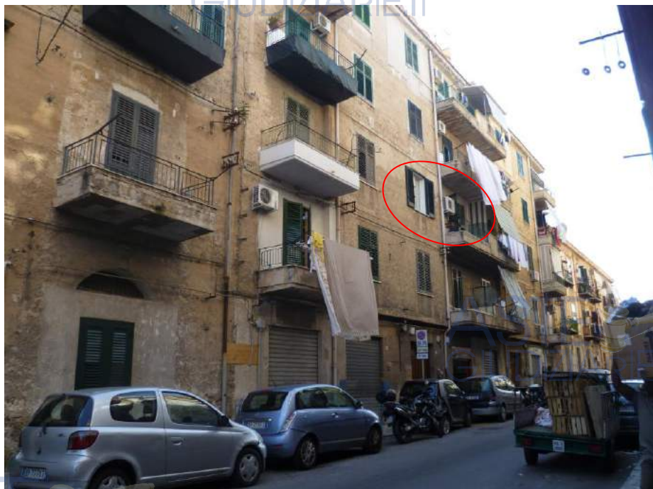
Fig. 7 Vista del prospetto del fabbricato su Via Monfenera.
