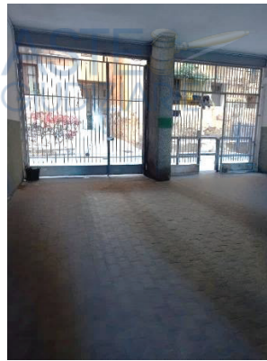
cancello che delimita la pertinenza dello stabile
