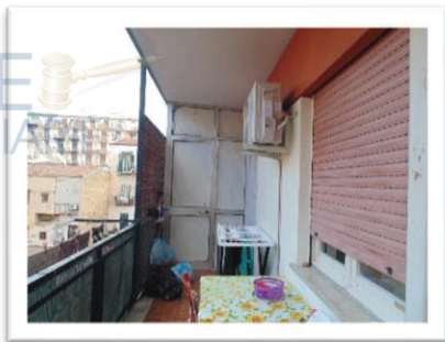
Balcone con veranda
