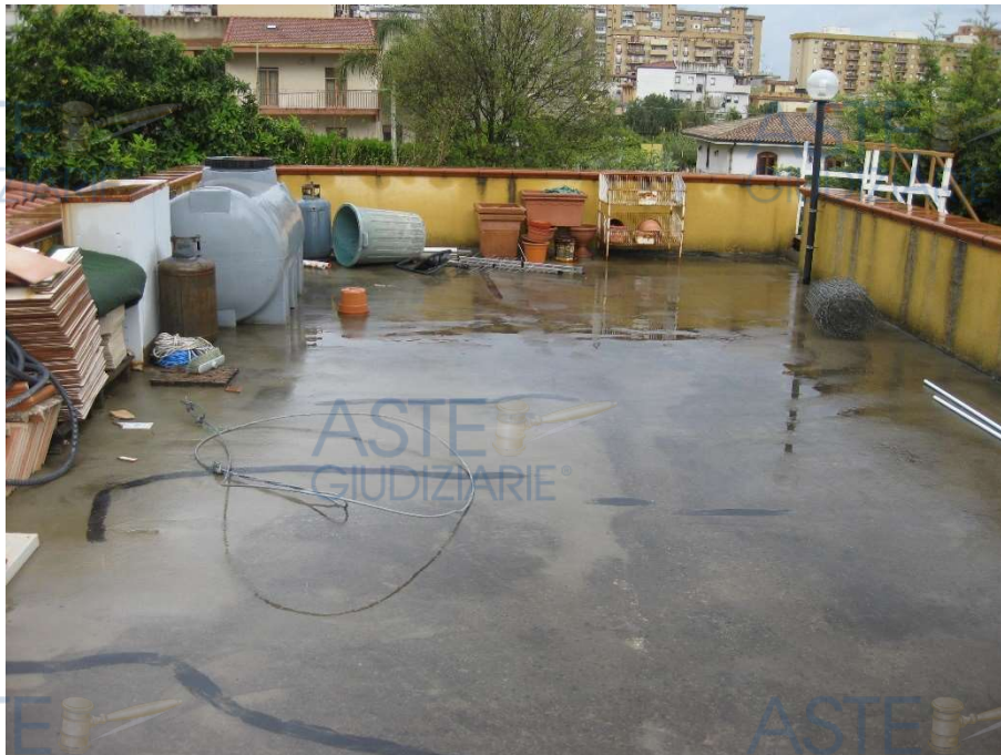
Foto 8: il lastrico solare a copertura del portico
