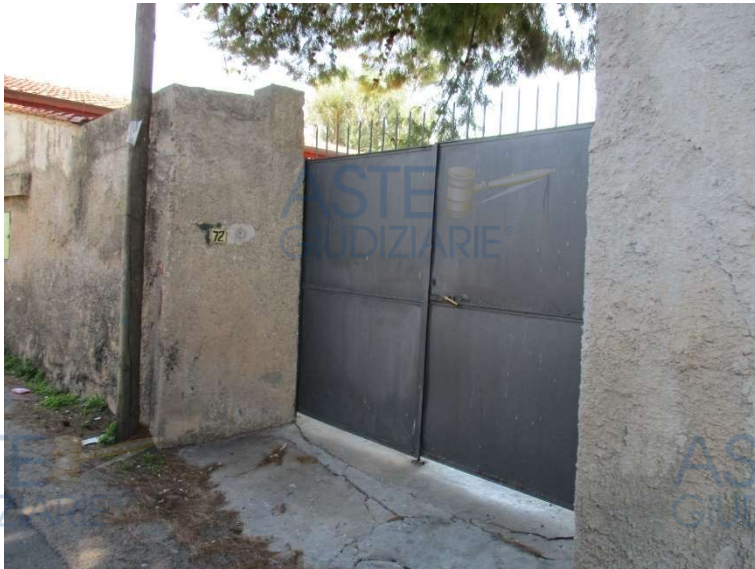
Foto 1: inquadratura, dalla via Palmerino, uno dei due cancelli d'ingresso agli immobili
