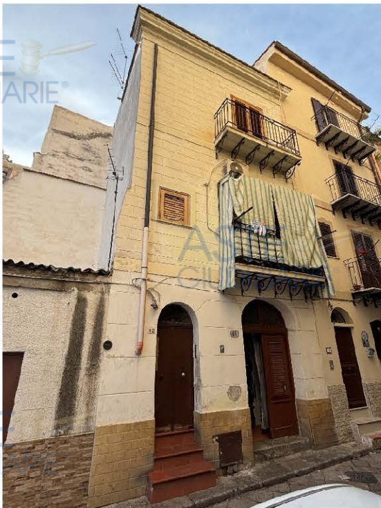
Foto n. 1 – Prospetto su via delle Pergole
