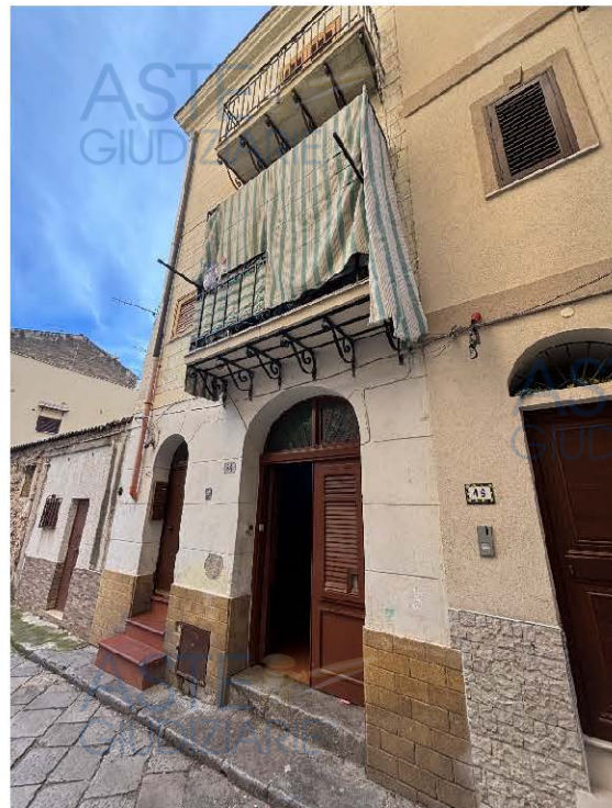
Foto n. 2 – Prospetto su via delle Pergole
