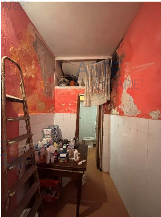
Foto n. 5 – Vano di retro
