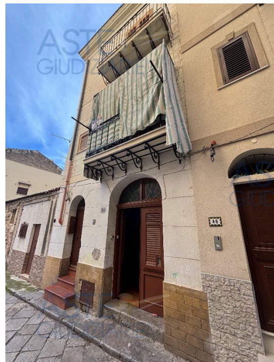
Foto n. 2 – Prospetto su via delle Pergole
