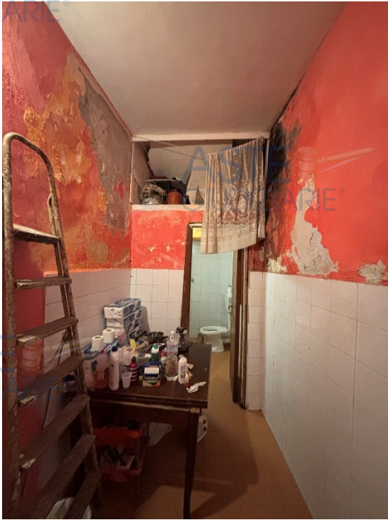
Foto n. 5 – Vano di retro
