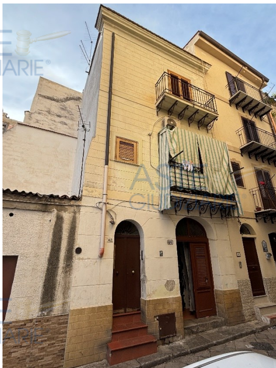
Foto n. 1 – Prospetto su via delle Pergole
