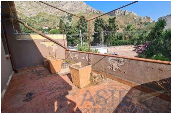
Foto n. 62 Vano letto – Terrazzo a livello
