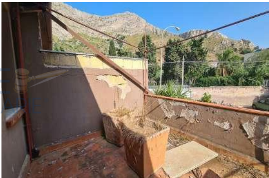
Foto n. 64 Vano letto - Terrazzo a livello
