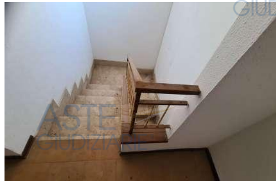
Foto n. 41 Vano scala - pianerottolo p. primo
