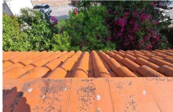
Foto nn. 68-69 Terrazzo a livello-muretti di delimitazione e cornicioni con soprastanti coppi
