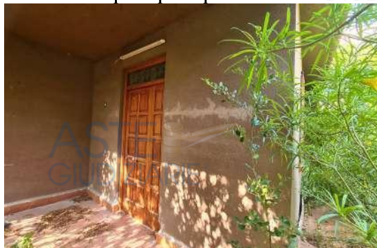
Foto n. 10 Prospetto principale-portoncino d'ingresso all'unità immobiliare
