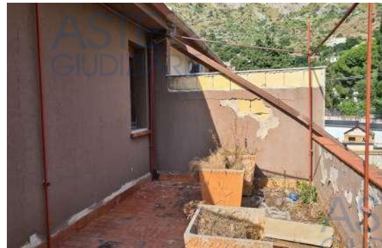
Foto n. 63 Vano letto – Terrazzo a livello
