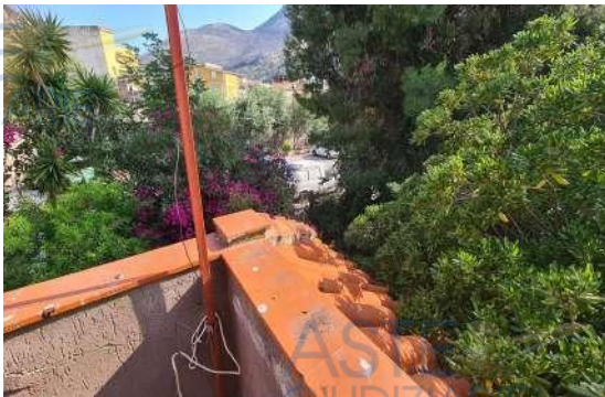
Foto nn. 70-71 Terrazzo a livello-muretti di delimitazione e cornicioni con soprastanti coppi
