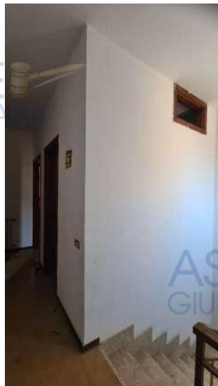
Foto n. 43 Infisso servizio igienico
