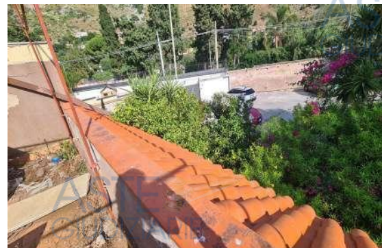
Foto nn. 66-67 Terrazzo a livello-muretti di delimitazione e cornicioni con soprastanti coppi
