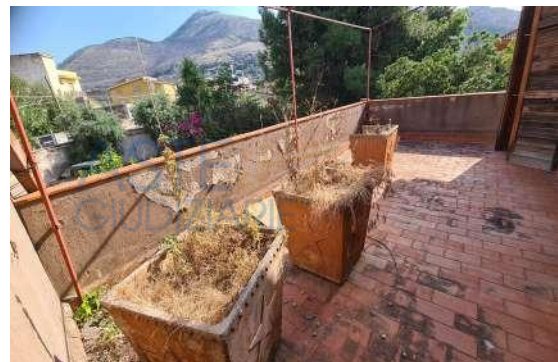
Foto n. 65 Vano letto - Terrazzo a livello
