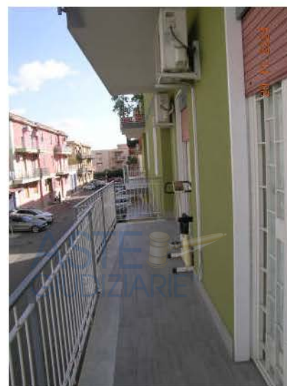
Foto 16 – Balcone su prospetto principale
