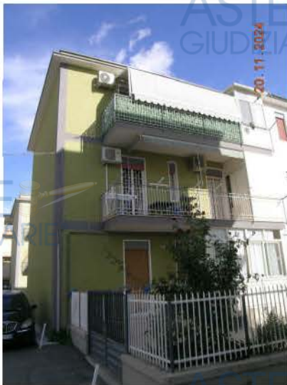
Foto 3 – Prospetto laterale e retroprospetto
