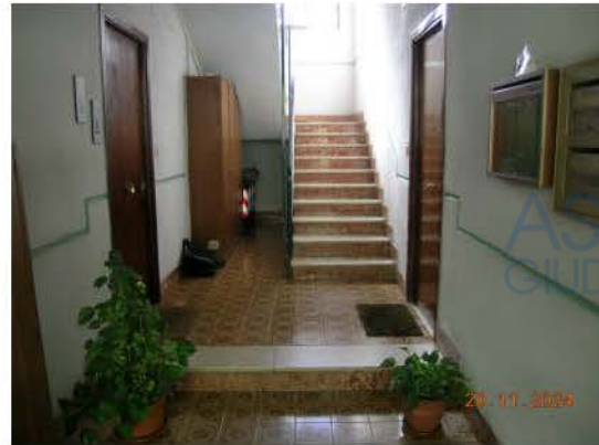
Foto 6 - Vano scala - Piano terra
