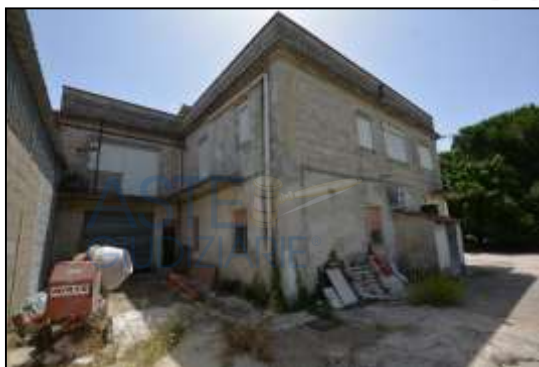
All. 9 – Foto 18 accesso dal retro prospetto
