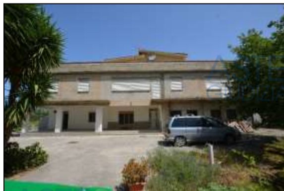
All. 9 – Foto 2 palazzina foglio 14 particella 343
