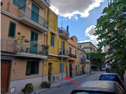
Fronte dell’edificio su Via Badia
