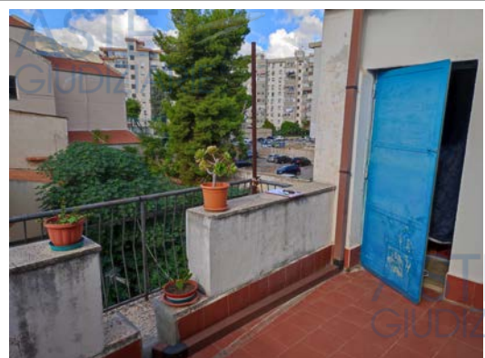
Vista dal terrazzo di piano II prospiciente la Via Badia
