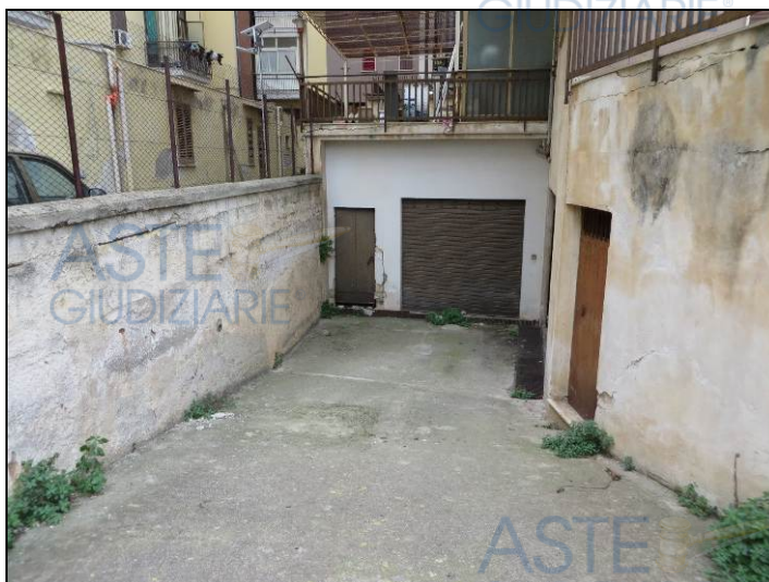
Rampa carrabile di accesso al piano seminterrato
