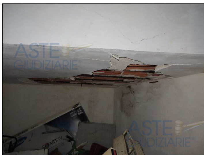
Interno dell'unità immobiliare interessata da sfondellamento del solaio
