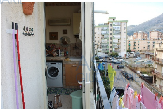
Veranda (ampliamento su cucina)
