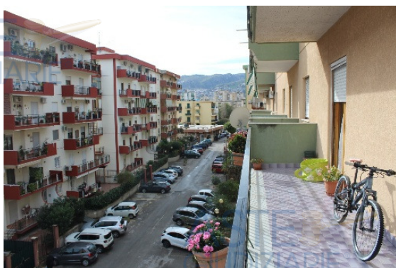
Prospetto su corte interna
