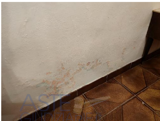
Fig. 28 efflorescenza dovuta all'umidità da risalita del terreno
