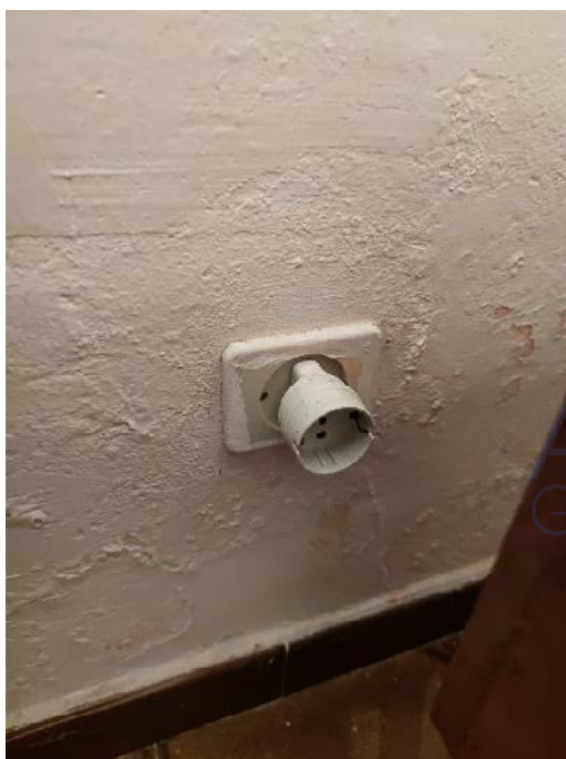
Fig. 28 efflorescenza dovuta all'umidità da risalita del terreno
