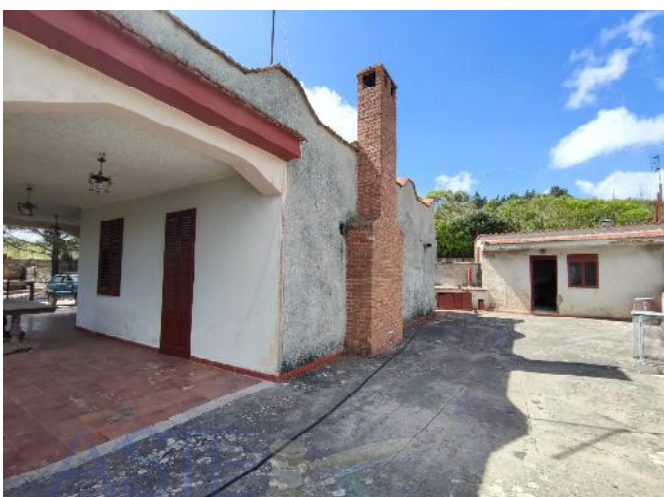
Fig. 26 vista del retroprospetto dell'immobile, sullo sfondo il corpo accessorio
