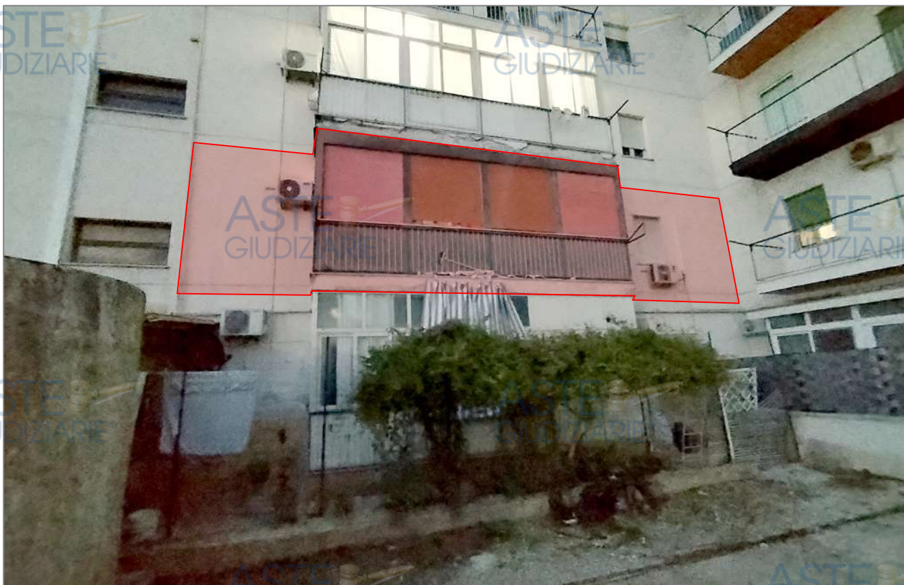
Prospetto esposto a sud-ovest.
