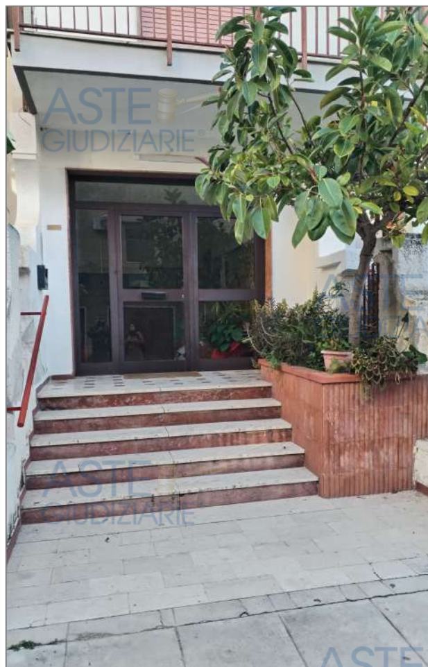
Portone di ingresso al fabbricato. Scala B
