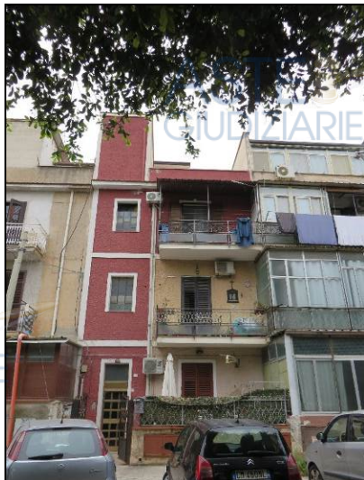
Edificio di via Pandora n. 10
