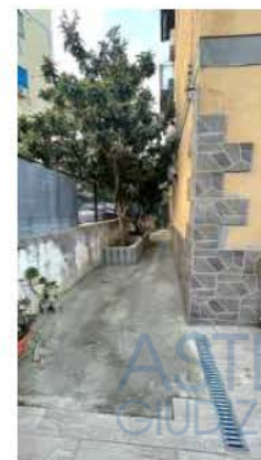
Vista della corte esterna
