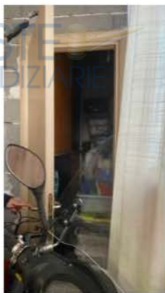
Vista del vano ripostiglio
