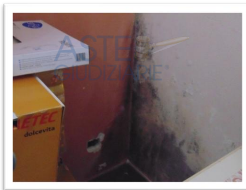
particolare delle macchie di umidità e muffa negli angoli
