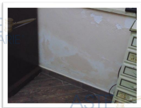
cameretta particolare sottofinestra intonaco scrostato
