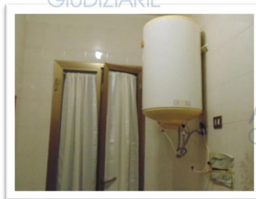
Bagno con particolare dell'infisso e del boiler, si notano le piastrelle a tutta altezza
