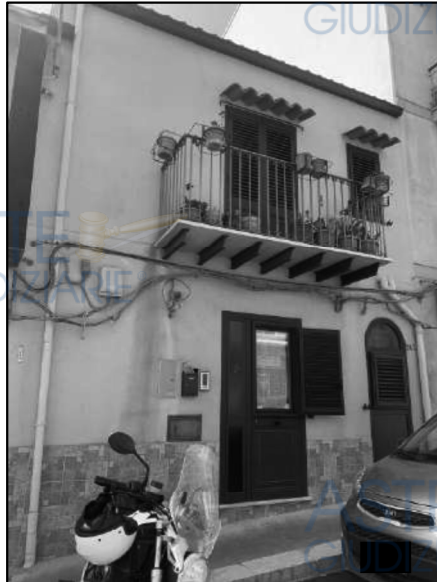
Foto n. 1 – Prospetto sulla via Provinciale
