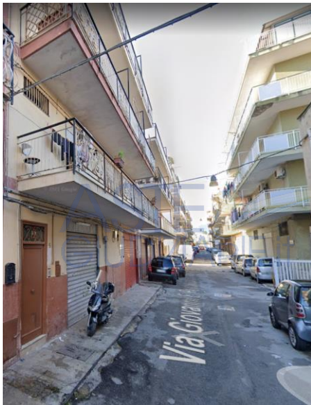
- Edificio, di quattro elevazioni f.t.
