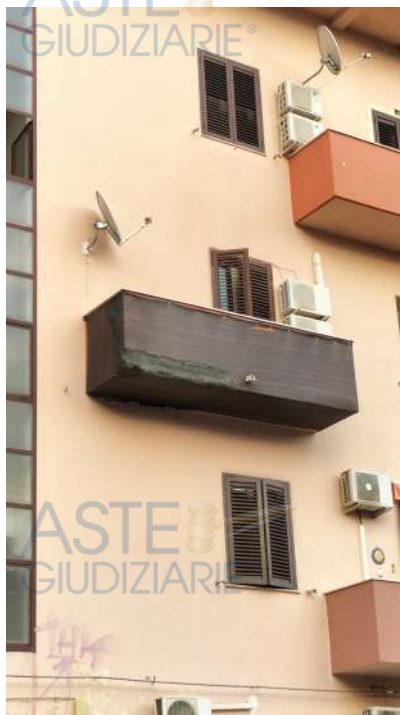
Balcone con rete di sicurezza
