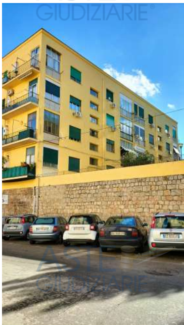
Edificio in cui ricade l'immobile dalla via Mongitore
