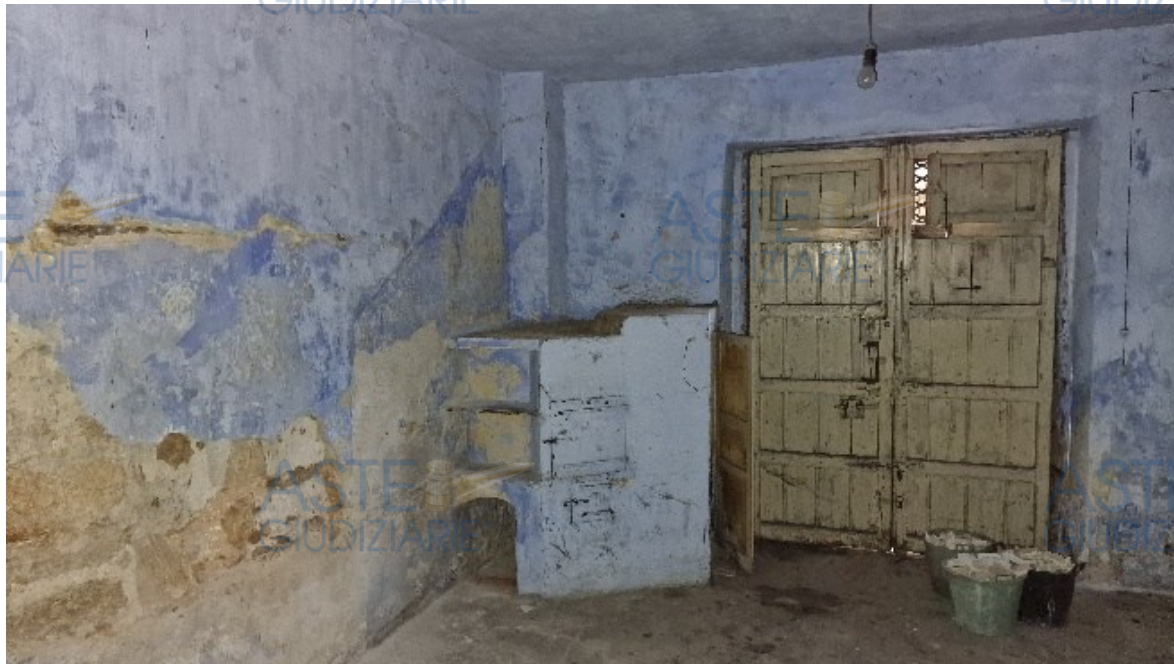
12. Interno. Particolare dell'angolo ove è ubicata la canna fumaria dismessa.
