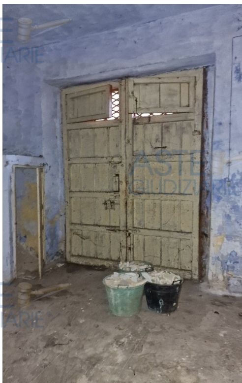
8. Portone d'ingresso visto dall'interno.
