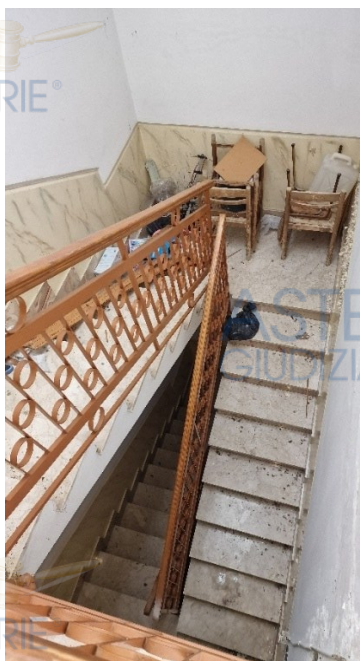
10. Vano scala tra il 3° ed il 2° piano.
