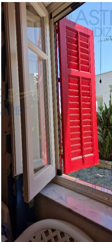
16. Particolare degli infissi.
