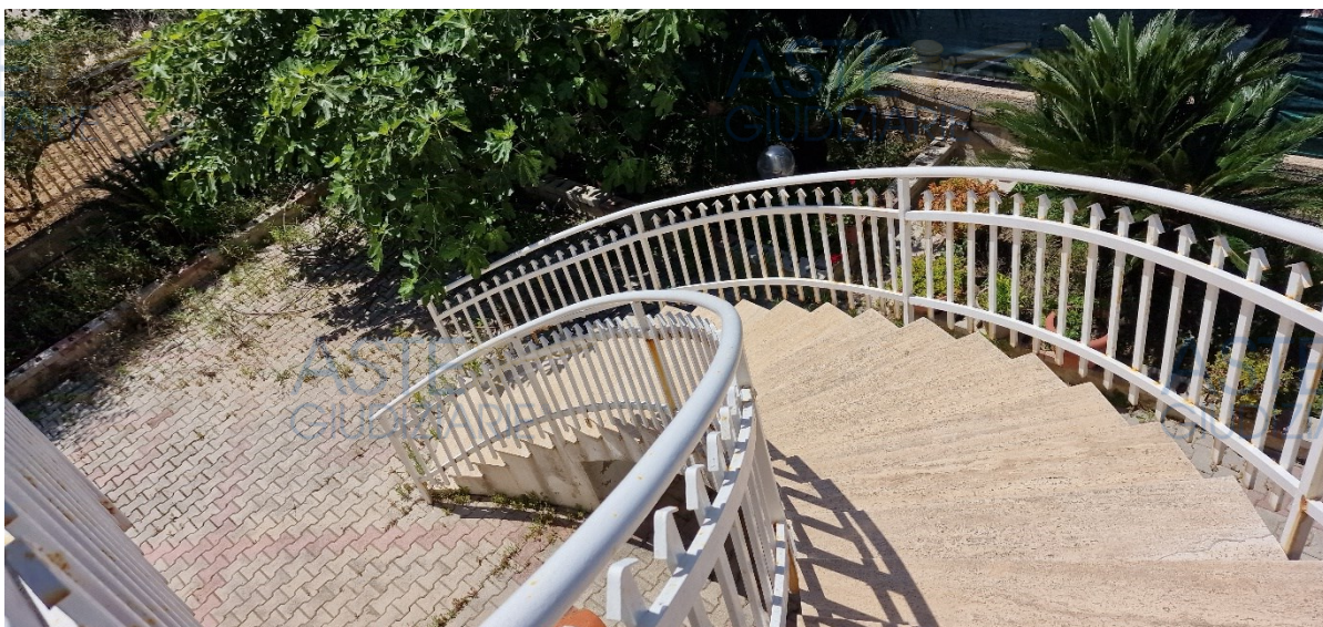
20. Particolare della scala esterna.
