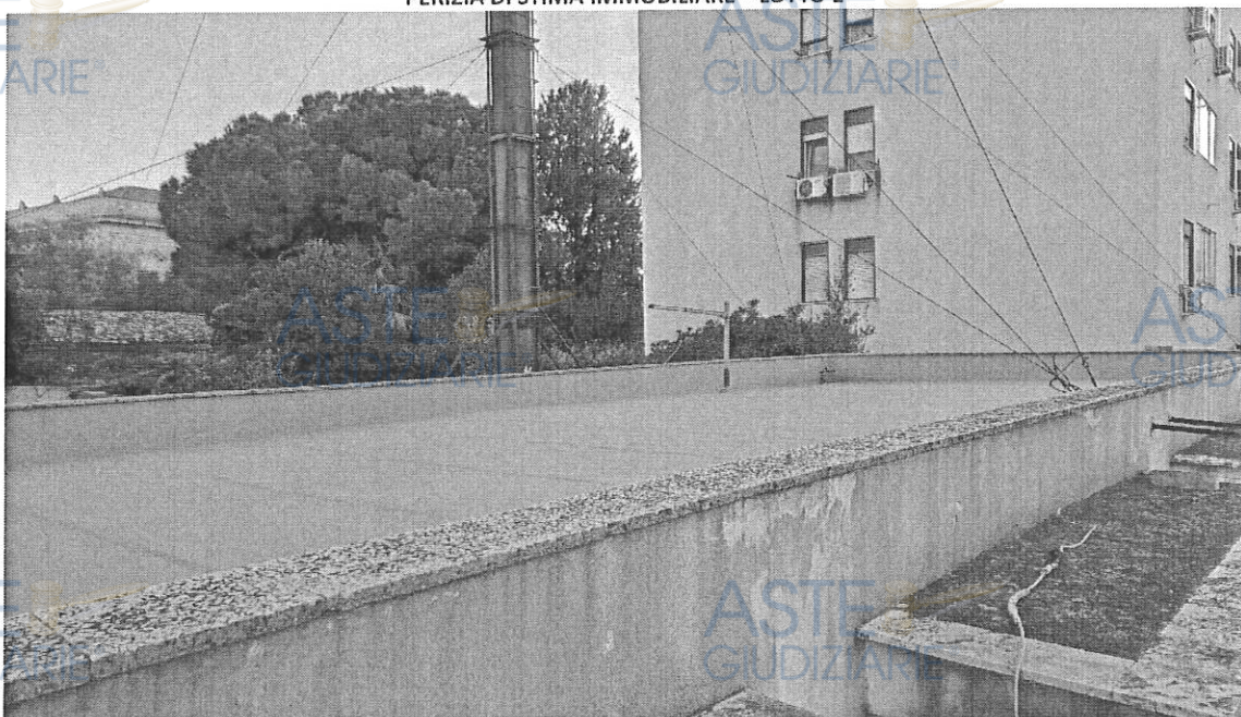
Fig. 8- Particolare della copertura piana del corpo di fabbrica originario.
