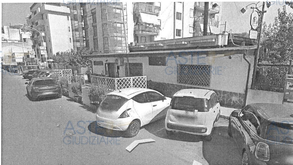
Fig. 5- Immagine tratta da Google Earth. In primo piano, il corpo di fabbrica isolato di un piano fuoriterra del LOTTO 1.
