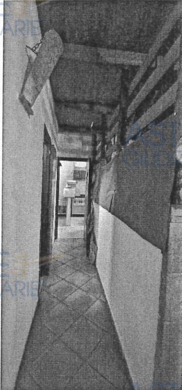
Fig. 14 - Corridoio di disimpegno.
