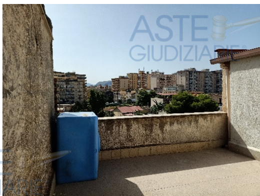
Terrazzo di copertura (su retro prospetto)
