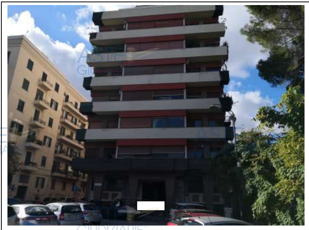
Foto n. 1 – Vista dell'edificio di cui fa parte l'ufficio oggetto di stima sito in Palermo, Piazza Goffredo Mameli n. 1, piano rialzato
