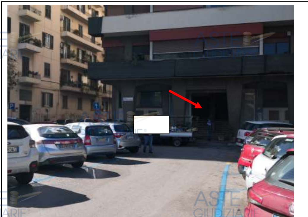
Foto n. 2 – Vista dell'edificio di cui fa parte l'ufficio oggetto di stima sito in Palermo, Piazza Goffredo Mameli n. 1, piano rialzato. La freccia rossa indica il portone di accesso all'edificio
