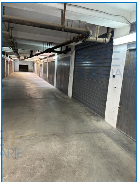
Foto n. 3 Corsia di accesso
