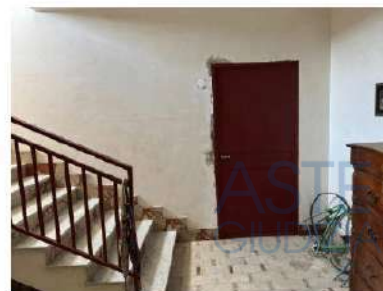
Foto 09 (ingresso Sub. 2 - P.T.)
