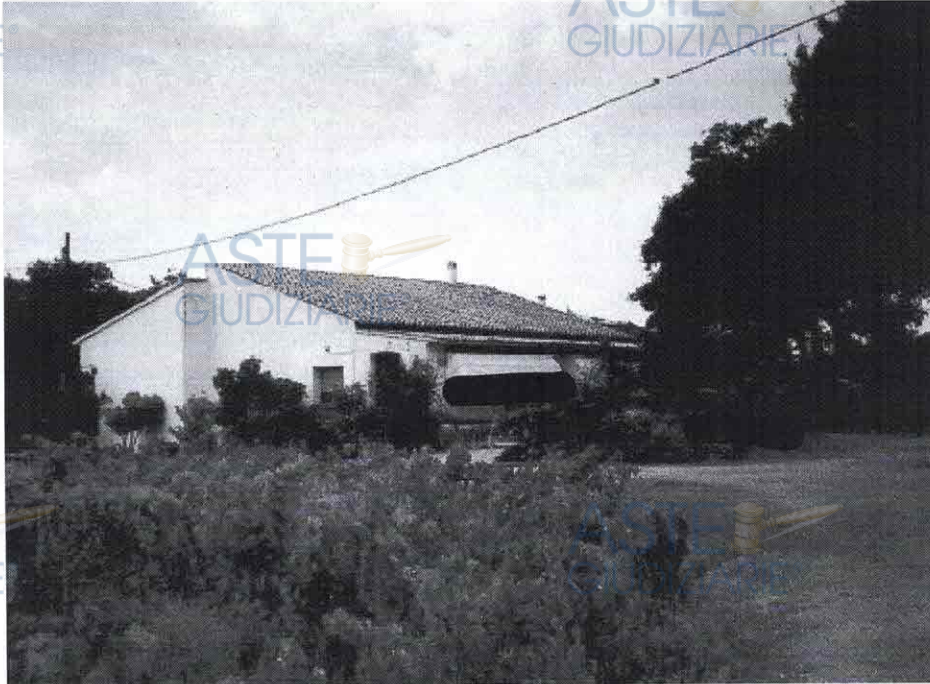
Fabbricato 2.a - Esterno
