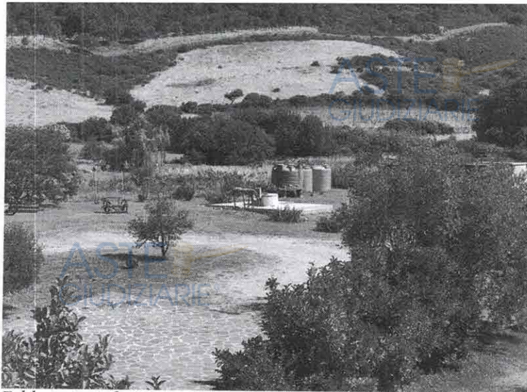
Fabbricato 2.f - Esterno
