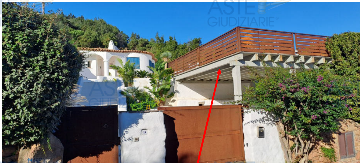
SOLARIUM ABUSIVO DA DEMOLIRE
